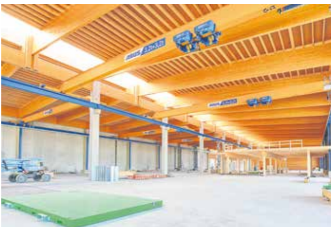
Im Januar ziehen hier 21 Arbeitsstationen für den Modulbau ein. Gesucht werden daher Facharbeiter aller Gewerke (u.a. Installateure, Bodenleger, Elektriker, Projektleiter).
