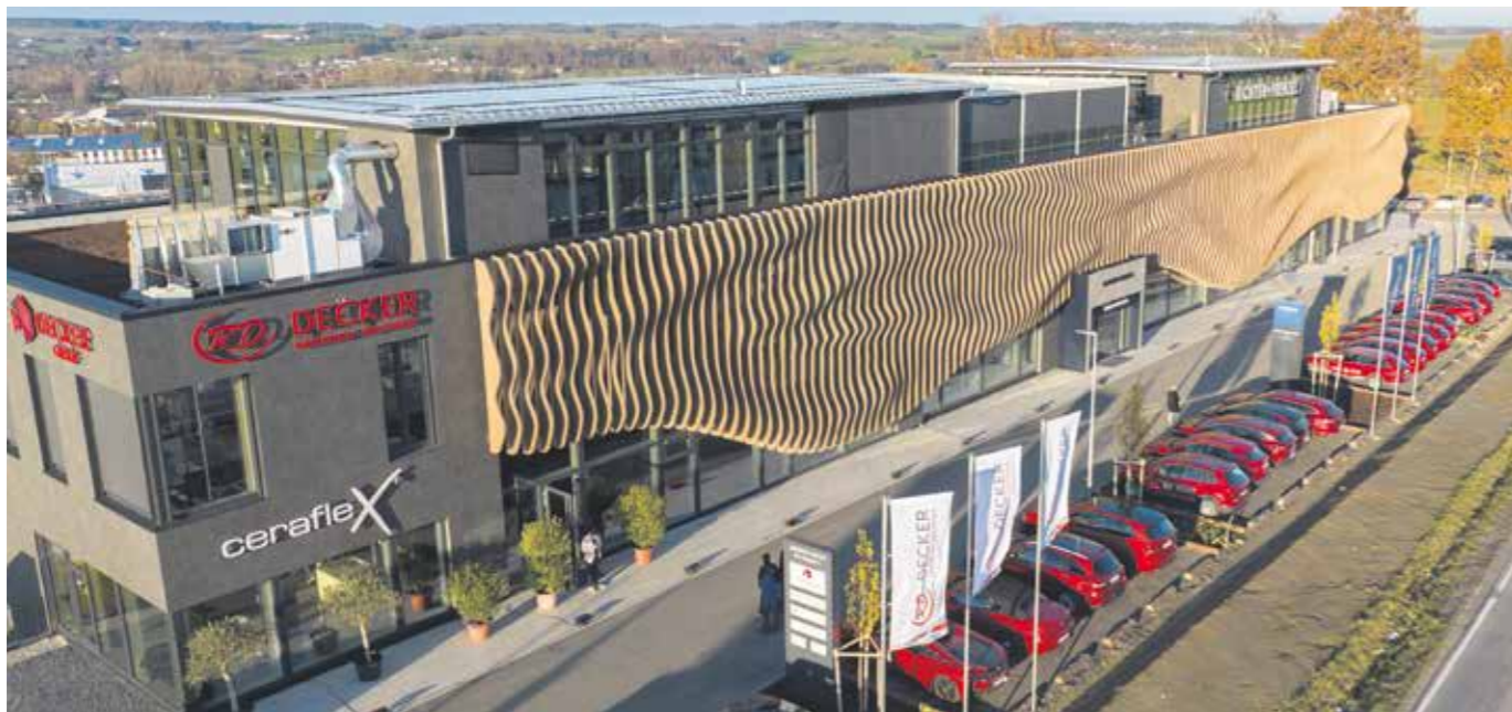
Hinter der modernen parametrischen Holz-Keramik-Fassade sind 12.100 m² Platz. Das Gebäude wurde komplett in Holz errichtet.
