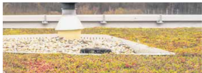
Für das begrünte Flachdach verwendet Decker recycelten Ziegelbruch
