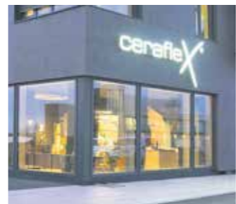
Großkeramik im Außenbereich
