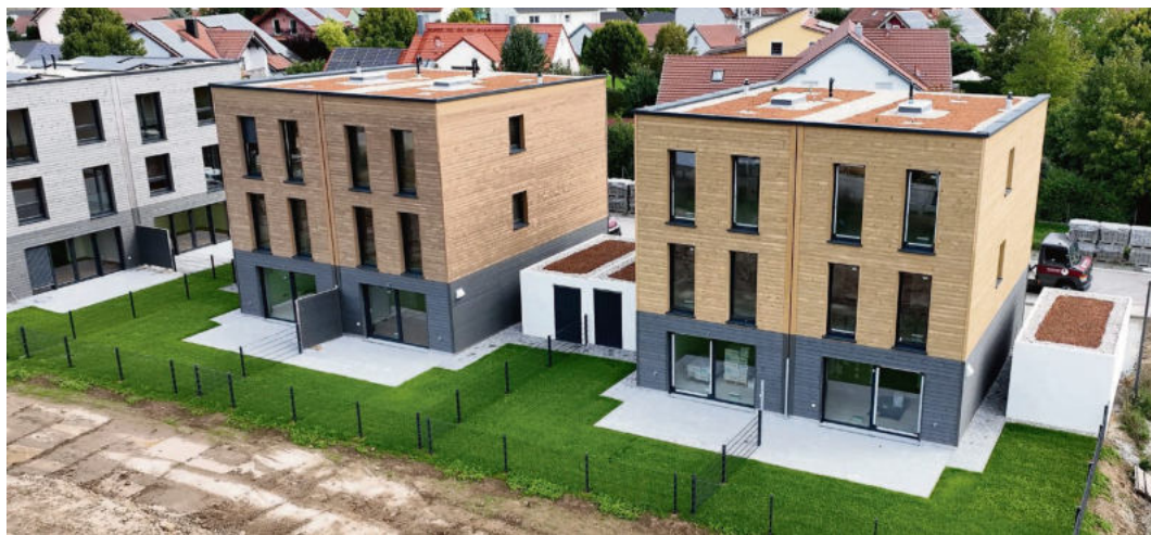
Fertiggestellte Doppelhäuser laden am Tag der offenen Baustelle zur Besichtigung ein.
