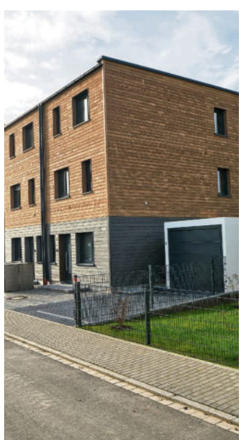
Eingangssseite der Doppelhäuser mit Garage
