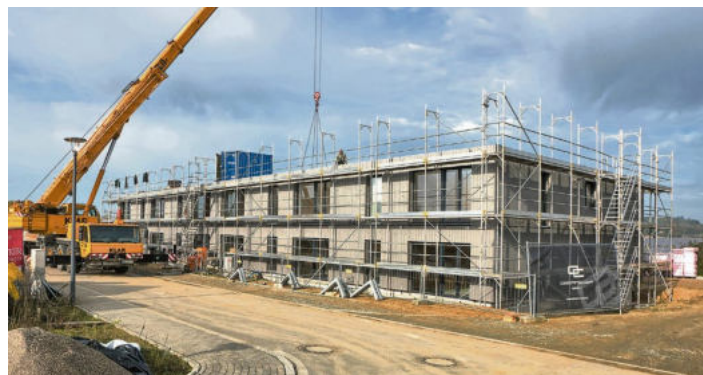
Das Mehrfamilienhaus im Rohbau. Hier können 2-, 3- und 4-Zimmerwohnungen im Erdgeschoss besichtigt werden.
