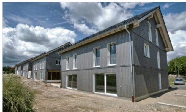
Bei Massivhäusern denkt man an Stein- oder Betonbauten. Die Doppelhäuser in Bergham bei Wasserburg/Inn haben Holzmassivwände (keine Ständerbauweise).
