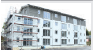
Wohnanlage „Am Herzogstand“
