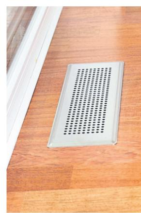
Teil des innovativen Lüftungssystems: Der Luftauslass im Boden.
