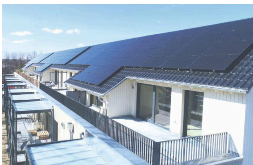
Die Mieter in der Siemensstraße beziehen günstigen Ökostrom – direkt von der Photovoltaikanlage auf dem Dach. Fotos: Decker
