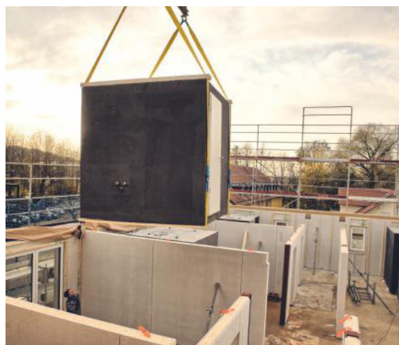
Vorgefertigte Badmodule werden in die Wohnungen eingesetzt und angeschlossen. Das spart Zeit und bietet eine hohe Verarbeitungsqualität.
