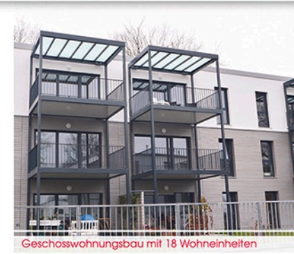
Geschosswohnungsbau mit 18 Wohneinheiten
