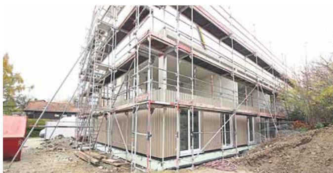
Im Erdgeschoss bereits fertig installierte Seitenelemente
