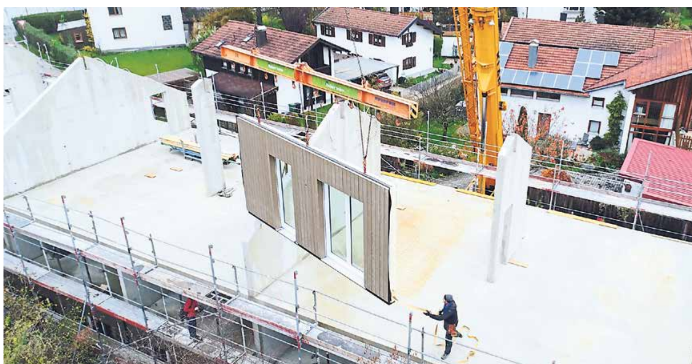
Montage eines fertigen Seitenelementes
