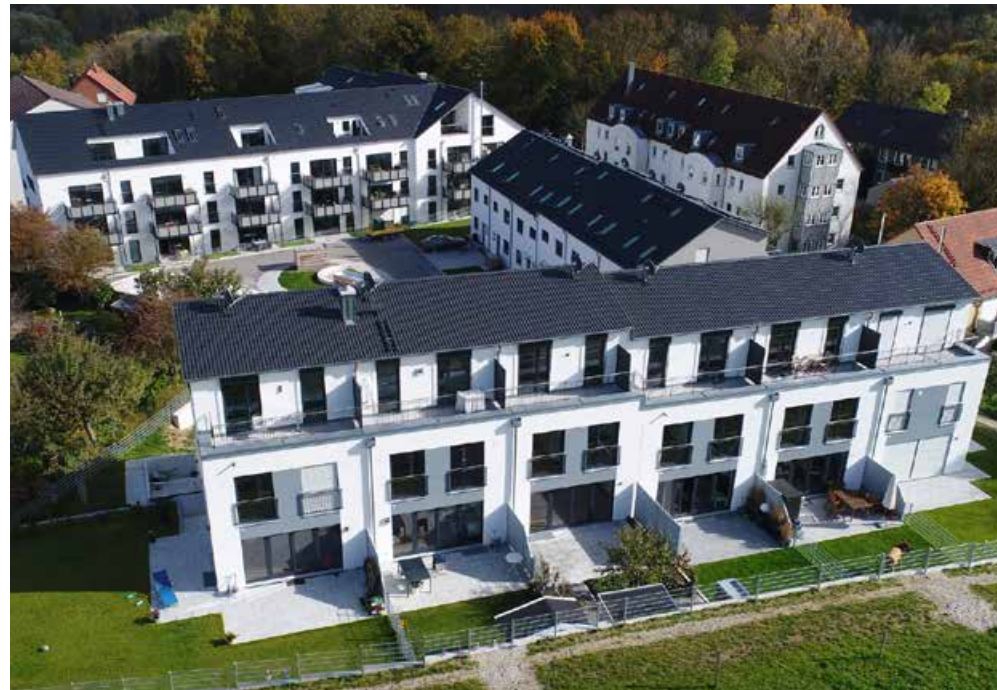
Aus der Vogelperspektive: Das Bauvorhaben im Oktober 2017
