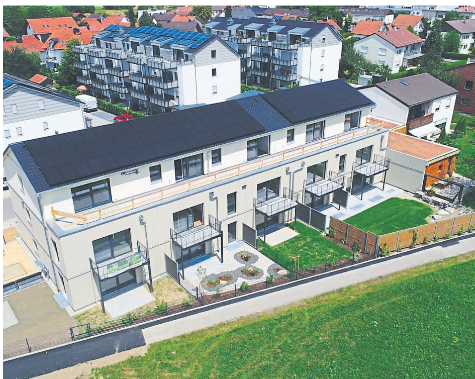
Dank des dunklen, randlosen Designs ist die Solaranlage auf den Dächern der Wohnanlage in der Zinniengasse besonders unauffällig. Fotos: Decker
