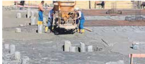
Im Vordergrund sind die tragenden Betonpfähle der Tiefgaragen-Bodenplatte erkennbar
