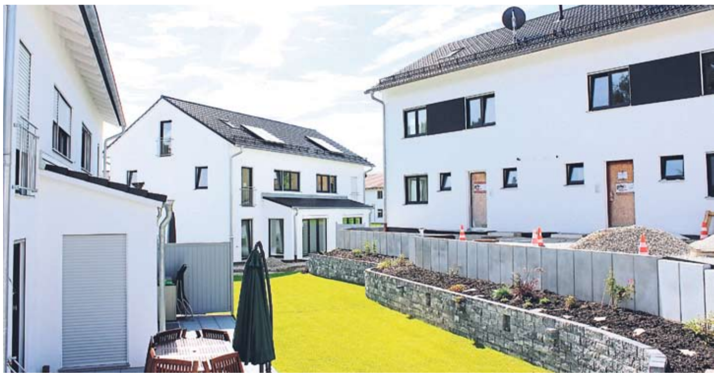
In Sankt Wolfgang befinden sich sechs Doppelhaushälften in der Fertigstellung. Die leichte Hanglage wurde durch eine Trockensteinmauer ausgeglichen.
