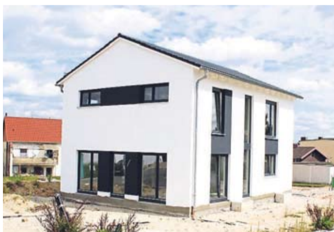
Das Einfamilienhaus im Innenausbau.
