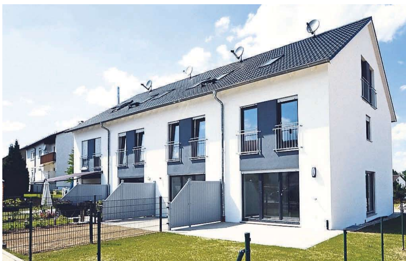
Fertiggestellte und bezugsfertige Reihenhäuser – hier im Bild ein Vierspänner.
